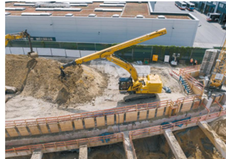
Auch für komplexe Tiefbauprojekte die richtige Wahl: Der Cat 352 mit Teleskoparm verfügt über eine maximale Reichweite von bis zu 42 Metern.
