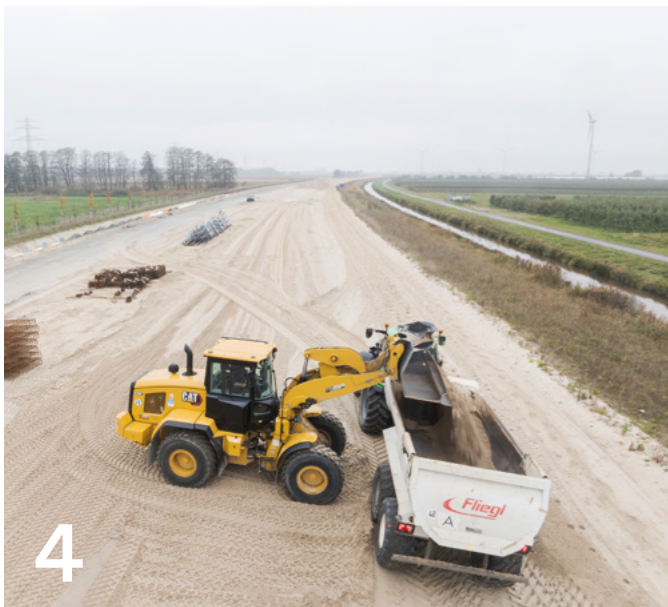
So weit das Auge reicht: Großbaustelle A26
