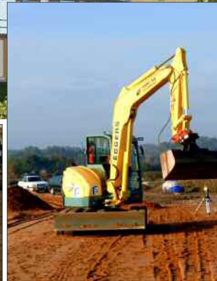
*Oben: Erdarbeiten für die geplante Ringstraße. Durch Bodenaustausch soll die Tragfähigkeit der Trasse verbessert werden.*
