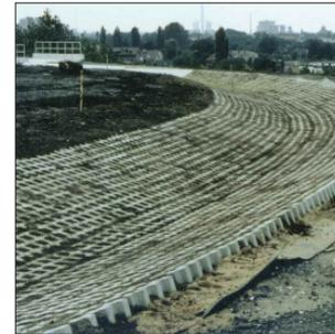
Das Fundament des fast drei Kilometer langen Entwässerungsgrabens, in dem sich das Niederschlagswasser sammelt. Er verhindert, dass sich neues Sickerwasser bildet.
