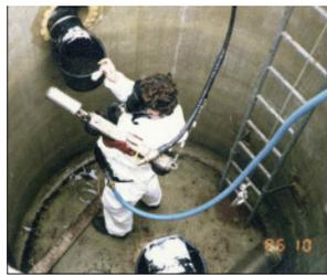
Hier wurde in einem Entgasungsschacht der Anschluss zur „Pipeline“ hergestellt, über die das Methangas in die Energieversorgung eingeleitet wurde.
