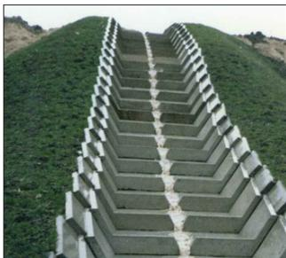
Eine der Kaskaden, über die das aufgefangene Regenwasser aus dem Entwässerungsgraben abgeleitet wurde.
