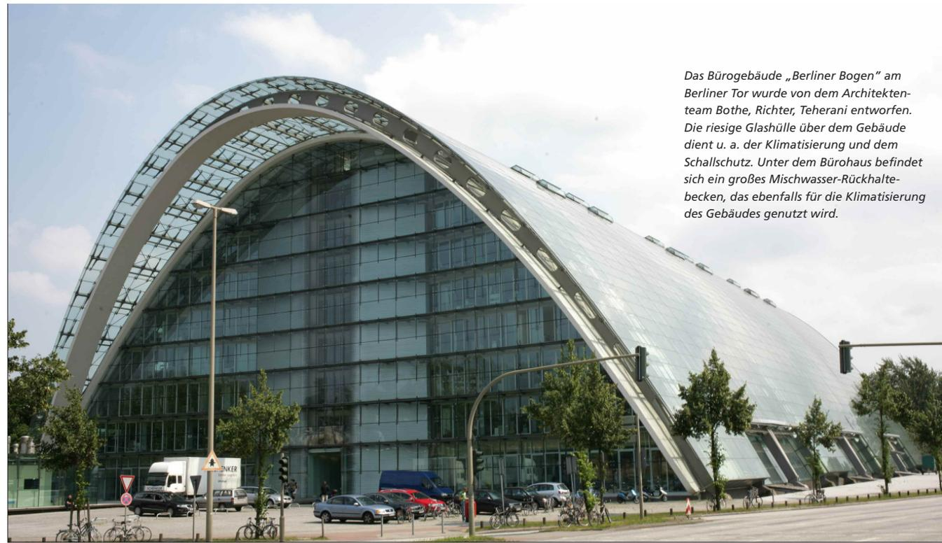
Das Bürogebäude „Berliner Bogen“ am Berliner Tor wurde von dem Architektenteam Bothe, Richter, Teherani entworfen. Die riesige Glashülle über dem Gebäude dient u. a. der Klimatisierung und dem Schallschutz. Unter dem Bürohaus befindet sich ein großes Mischwasser-Rückhaltebecken, das ebenfalls für die Klimatisierung des Gebäudes genutzt wird.
