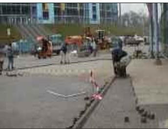
*Bilder links: Bauarbeiten für eine der Zufahrtrampen und die Verlegung von Verbundpflaster durch die EGGERS Umwelttechnik.*
