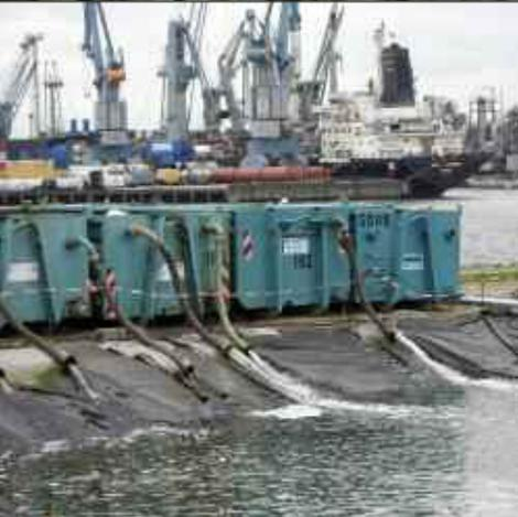
Für den Bau der Unilever Hauptverwaltung direkt an der Elbe wird das Grundwasser mit 16 Schwerkraftbrunnen abgesenkt. Je nach Elbwasserstand werden stündlich 120 bis 250 m<sup>3</sup> Wasser zur Wasseraufbereitungsanlage transportiert, um eine Enteisung durchzuführen. Im Bild die Einleitung des abgepumpten Grundwassers in das Wasserhaltebecken.
