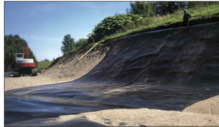
Einige Hektar PEHD-Folie wurden verlegt. Sie ist in die Mergelschicht eingebettet, die die Deponiekuppe gegen das Eindringen von Regenwasser schützt.
