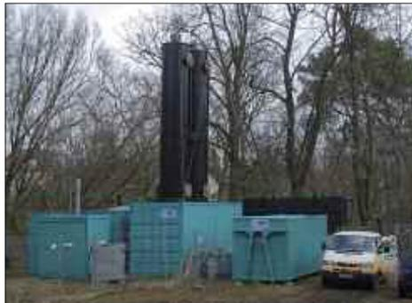
Grundwasserförderung und -sanierung auf einem ehemaligen Militärstandort in Dallgow-Döberitz bei Berlin. Das geförderte Wasser wird mittels Stripanlagen aufbereitet.
