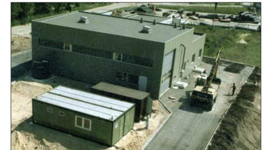
Das austretende belastete Sickerwasser wurde in eine für die Sanierung errichtete Sammelstation geleitet und in einem dreistufigen Aufbereitungsprozess von Schadstoffen befreit. Die von Eggers optimierte Anlage ist heute noch in Betrieb.
