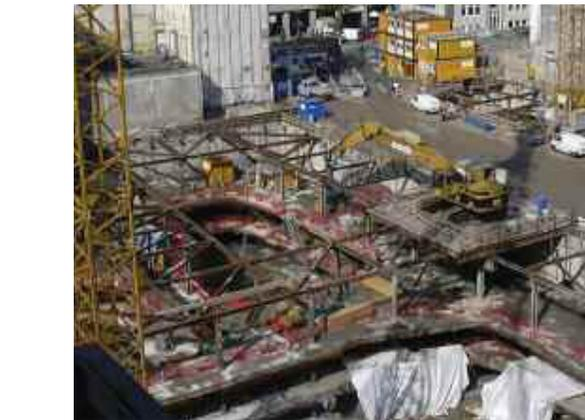
*Der Bau der Europa-Passage im Zentrum Hamburgs stellte hohe Anforderungen an den Tiefbau. Mitten im Stadtverkehr wurde eine 22 m tiefe Baugrube ausgehoben. 30.000 t Abbruchmaterial und 220.000 m<sup>3</sup> Aushubboden mussten abtransportiert und entsorgt werden.*
